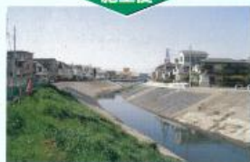
下流から福原橋を望む
