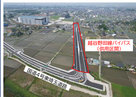
【越谷野田線バイパスと国道4号東埼玉道路の同時供用】 (令和7年6月1日)
