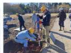
杭打機による打撃施行
