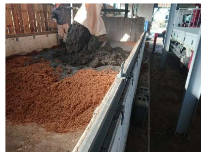
脱水土混合状況
