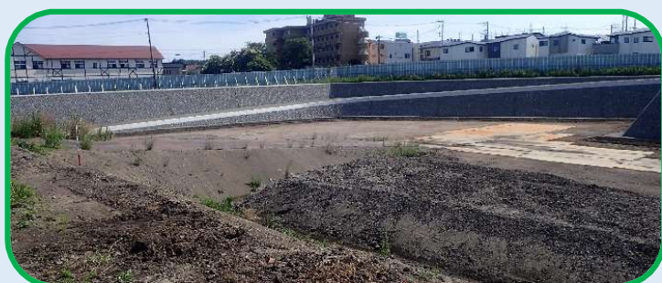
与野中央公園調節池護岸工事
