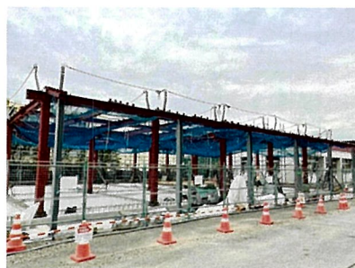
▲工事中の情報サイエンス棟(出典 埼玉県HP)
