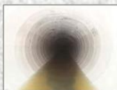
工事完成後の下水道管の内部
