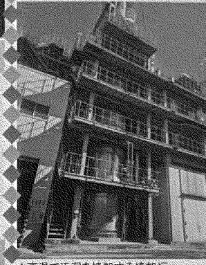
▲高温で汚泥を焼却する焼却炉
