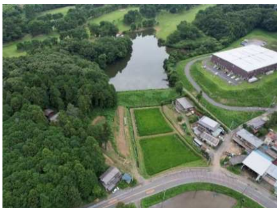
滑川町ため池群1地区（大沼 現況全景） 滑川町大字福田
