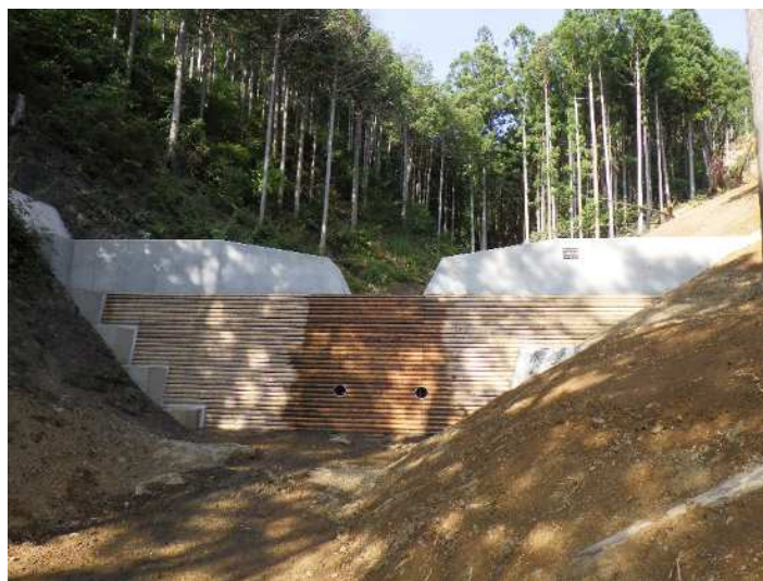
県産木材の利用を図った治山ダム（治山工事）
