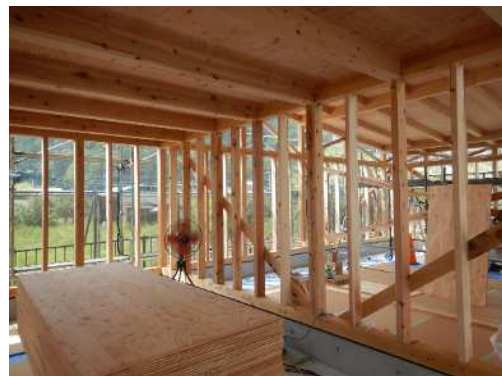
東秩父村役場 倉庫新築
