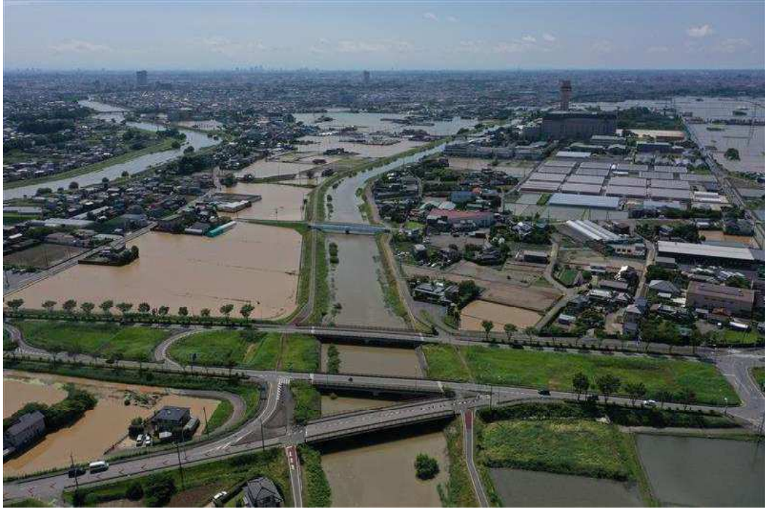
令和5年6月梅雨前線及び台風第2号による大雨に伴う水害(越谷市)
