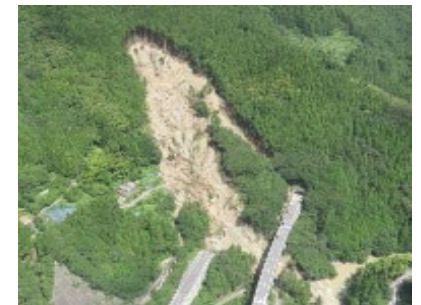
豪雨による大規模な山地災害 (2018年7月 高知県大豊町)
