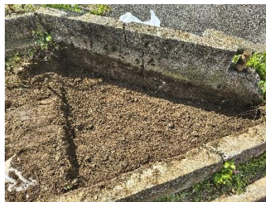
10センチほど掘削
