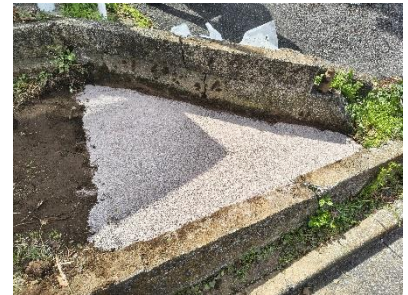
人工砂を敷設
