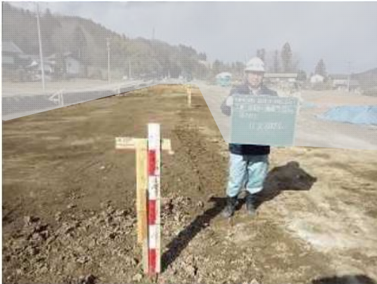
仕上り厚管理（施工前）
