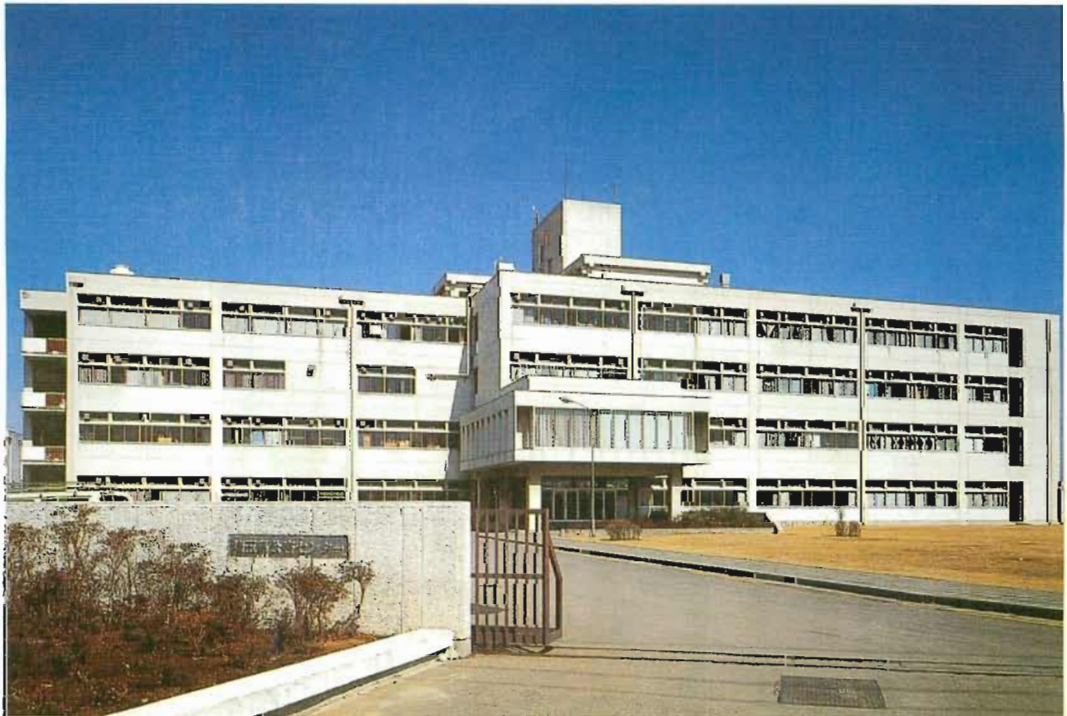
▲ 昭和47年3月に完成した現在の庁舎。衛生研究所との合同庁舎で、当時としては最新鋭の設備を誇っていた。
