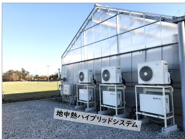
図3 ビニルハウスへの地中熱利用システム設置
