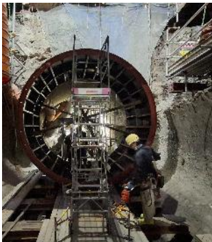
破損した下水道管の代わりに敷設した新しい下水道管（鋼製セグメント）
