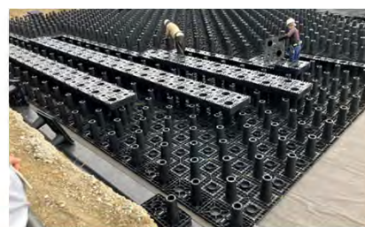
雨水貯留槽施工
