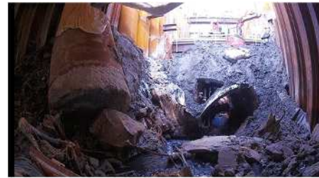
写真1 下水道管崩壊部内部の様子
