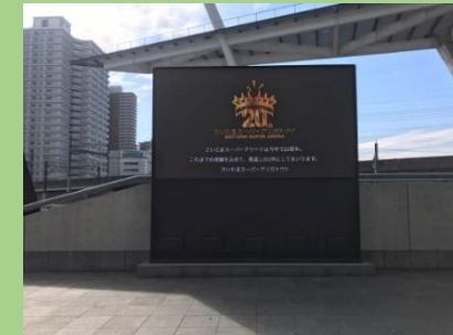
■Aゲートに設置した200インチ屋外型LEDビジョン 幅4.5m、高さ2.5mのスクリーンに映像表示
