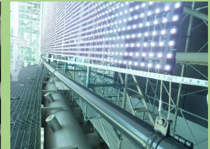
■Cゲートに設置した700インチ透過型LEDビジョン 約40万個のLED素子を使用し、幅16m、高さ9mのスクリーンに映像表示
