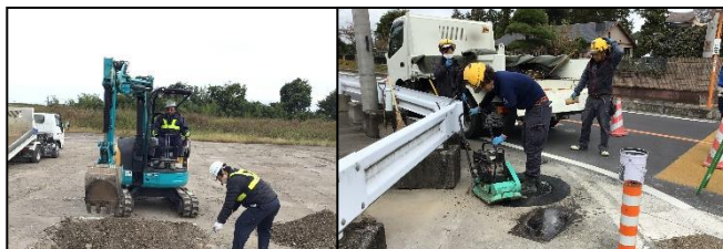
仮設沈殿池掘削・人孔補修(建設協)
