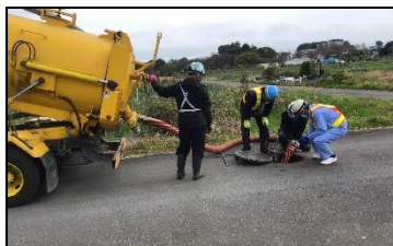
吸引車による汚水の移送(管路協)
