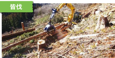
皆伐 森林を伐採し、丸太を必要な規格に切り分けている様子
