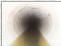
工事完成後の下水道管の内部
