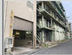
燃烧灰の製造
