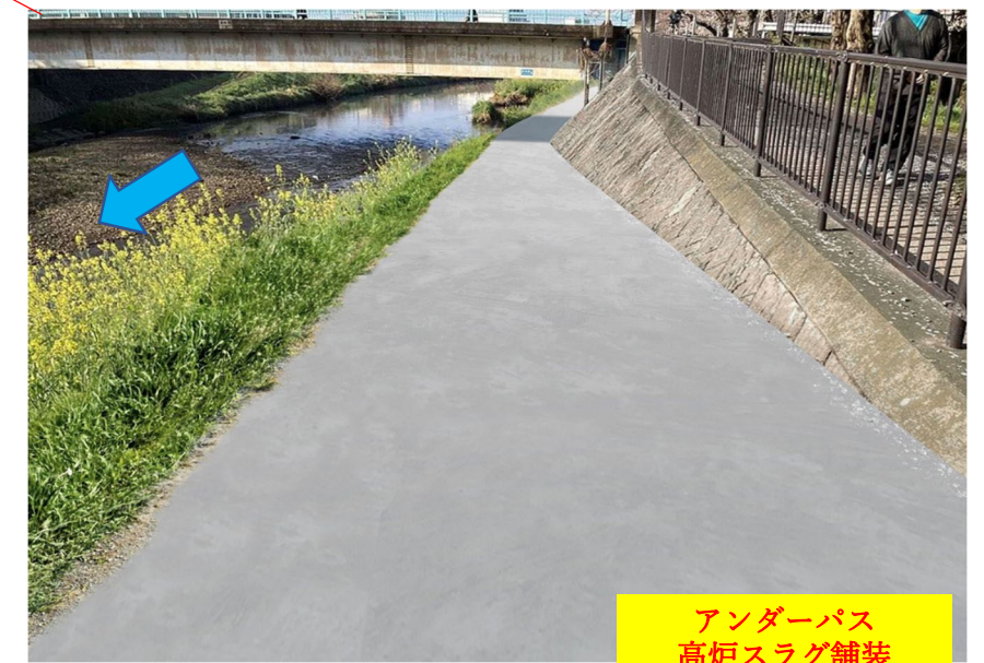
管理用道路（桜堤） 高炉スラグ舗装
