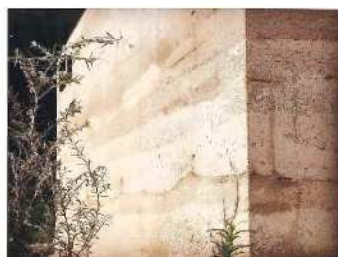
※民間施設 版築風の擁壁
