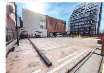
※熊本県私立保育園：園庭駐車場整備工事
