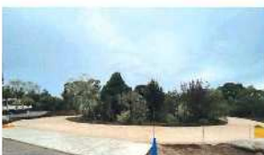
※民間施設内舗装
