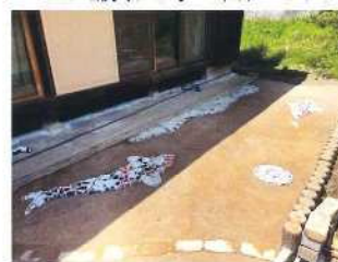
※個人宅外構におけるデザイン施工
