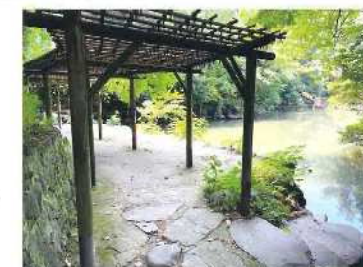
※東京大学：三田池田周遊舗装 施工後24年経過写真
