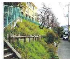
※京大阪市教育委員会：中学校法面改修工事
