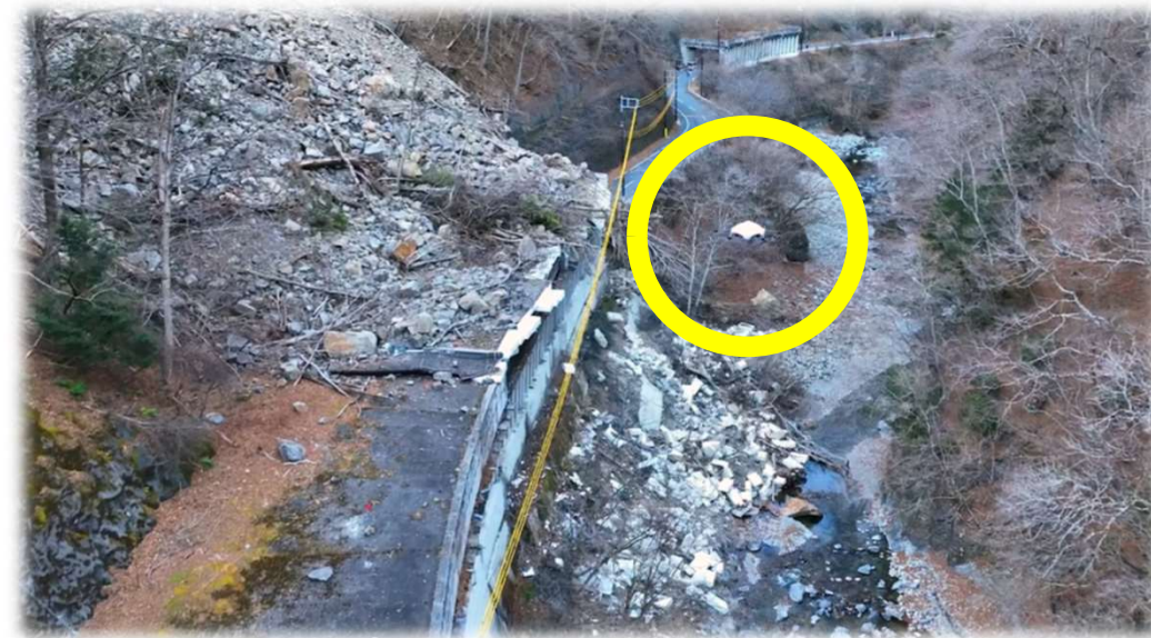
■ 崩落個所の上空を物資配送で飛行するドローン（囲み枠内）
