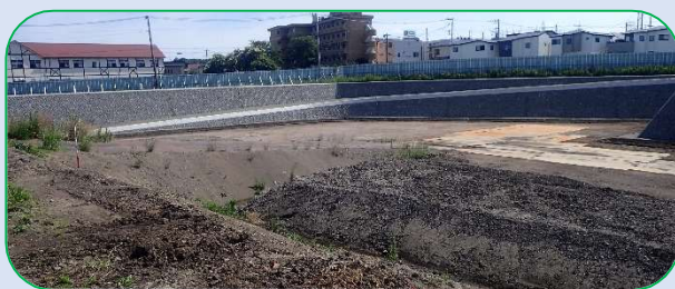
与野中央公園調節池護岸工事
