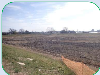
緊急浚渫工事(新河岸川掘削工)
