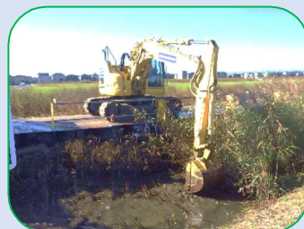
綾瀬川河道掘削
