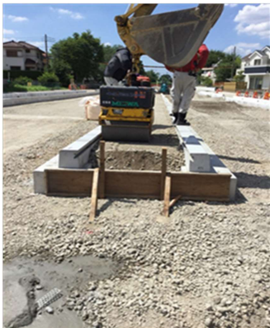
縦断側溝施工
