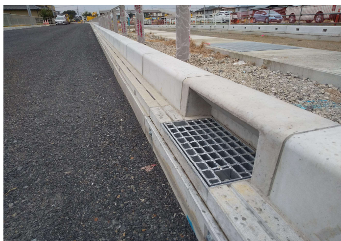
縦断側溝施工
