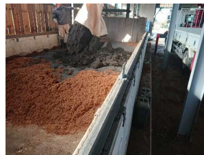
脱水土混合状況
