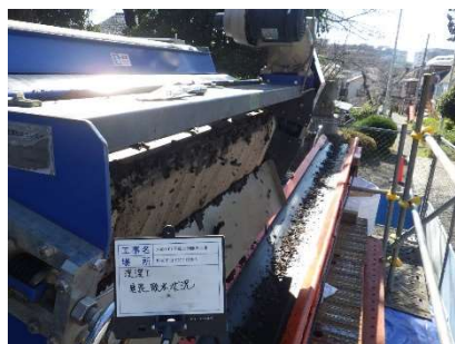
脱水された堆積土
