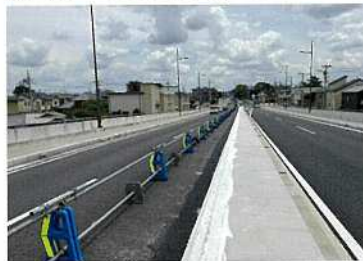
吉川橋工事中①(6月上旬)
