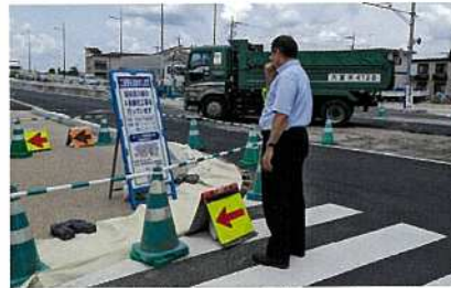
吉川橋工事中②(6月上旬)
