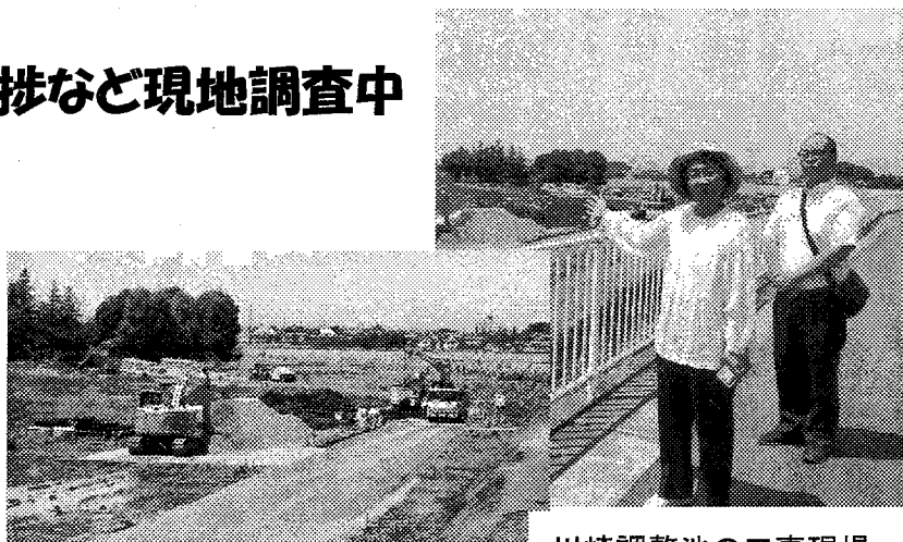
川崎調整池の工事現場
