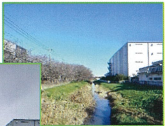
上：工事前 左：工事中
