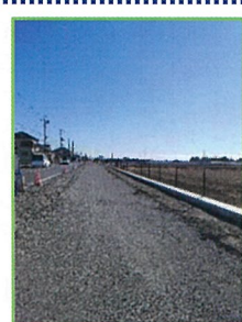
工事が進む「県道阿佐間幸手線」（奥に市道栗橋680号線）
