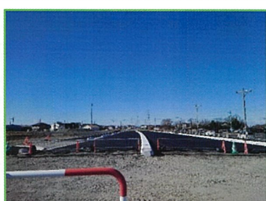
工事中の「県道加須幸手線」右側に「宝泉寺池」
