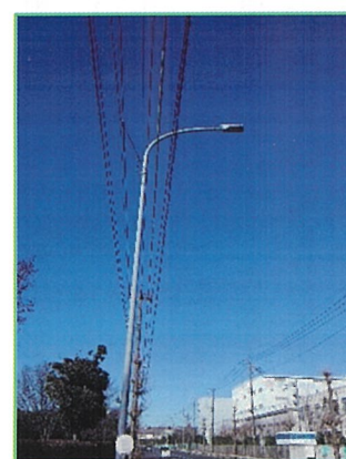
県道に設置された照明灯
