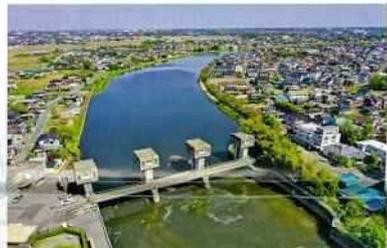
古利根堰は春日部市、草加市、越谷市、八潮市、三郷市、吉川市、松伏町の6市1町、1,761.4haの水田に農業用水を供給する取水堰です。葛西用水路土地改良区が管理しています。一級河川大落古利根川の越谷市大字大吉地先と松伏町大字松伏地先に位置します。
