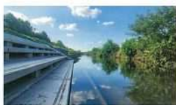
芝川で2か所の護岸が整備されました。(仙山橋・防災センター東側/合併記念公園南東部)
