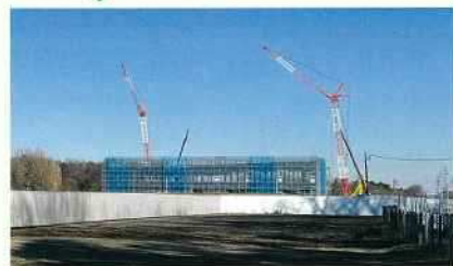
廣大跡地立地企業の工事風景(撮影:令和7年1月)
