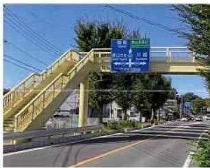
歩道橋改修工事
