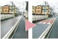
▲ 要望いただいた通学路の安全対策「道路ハンプ」で車速の抑制
