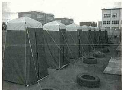
マンホールの上に設置しますが、事前にマンホールの加工が必要です。本館直結型、流下型、貯留型の3つの形式があります。
