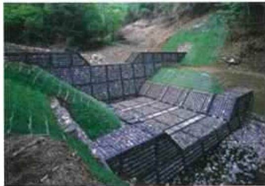
○比企郡ときがわ町大字大野地内において砂防施設の改築工事を進めている。○空堀川は、えん堤にクラックがあり、現行の基準を満たすよう改築を実施する。現況流路工は、地すべりの影響を受け、壊滅的な状況である。○中力川は、5基の床固にクラックがあり、現行の基準を満たすよう改築を実施する。○現在、空堀川、中力川の渓流保全工を進めている。
