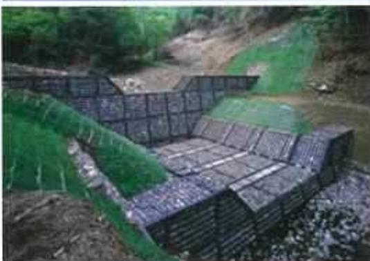
○比企郡ときがわ町大字大野地内において砂防施設の改築を進めている。○空堀川は、えん堤にクラックがあり、現行の基準を満たすよう改築を実施する。現況流路工は、地すべりの影響を受け、壊滅的な状況である。○中カ川は、5基の床固にクラックがあり、現行の基準を満たすよう改築を実施する。○現在、空堀川、中カ川の溪流保全工を進めている。
