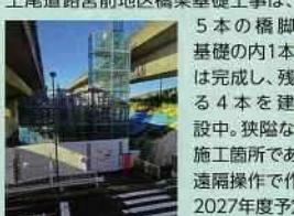
5本の橋脚基礎の内1本は完成し、残る4本を建設中。狭隘な施工箇所であるため、「スリムケーン工法」にて遠隔操作で作業しているとのことでした。完成は2027年度予定。大変な工事だと実感しました。
