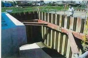
4月26日の撮影日は越流堤の基礎工事が完了したところでした。越流堤とは、堤防の一部を低くして、洪水が越流堤の高さを越えた時には洪水の一部が調節池に流れ込む構造になっています。
