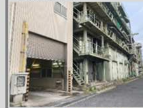
燃烧灰の製造
