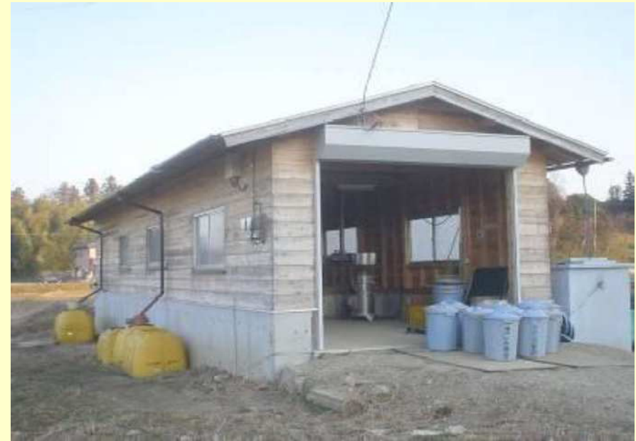
地場産バイオガスプラント 地域コミュニティー用 (容積10～100m 3 )
