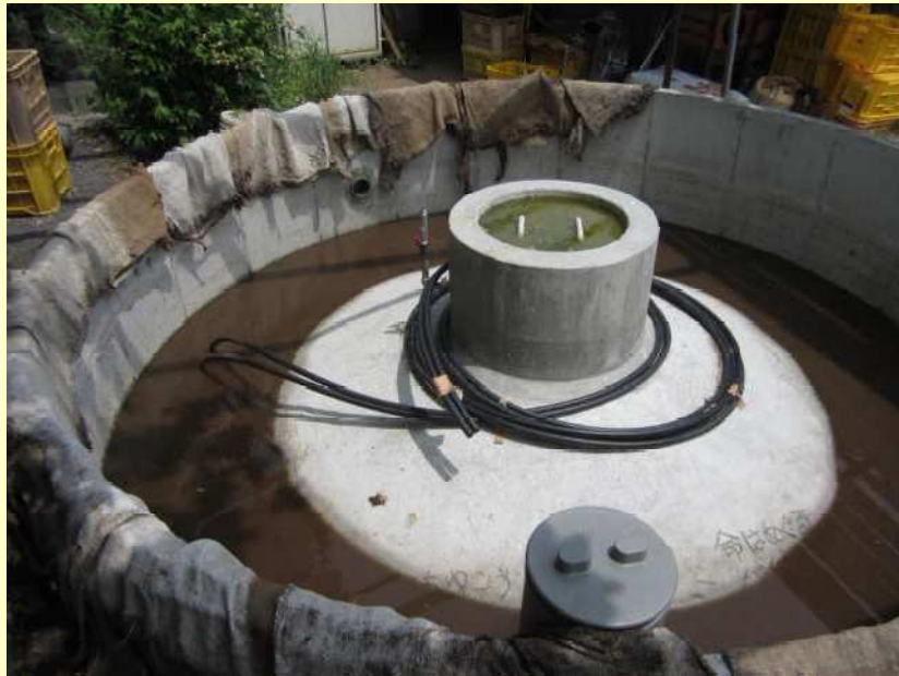
手作りバイオガスプラント 小規模畜産・農家向け (容積1～10m 3 )
