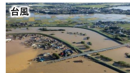
令和元年東日本台風による東松山市河川氾濫（埼玉県撮影）
