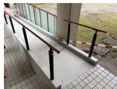
スロープ整備
