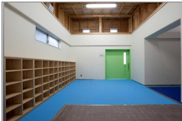
写真⑥ プール内部 小屋梁構造材：埼玉県産杉無垢材 野地板：埼玉県産杉無垢材板張り 下足入れ：埼玉県産杉無垢修正材
