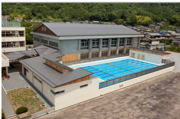
写真① 体育館・プール外観（西側） 新築工事により平成27年6月に竣工 南側にプールを設置、体育館南側に窓を設置することで、十分な採光を取り入れられる。
