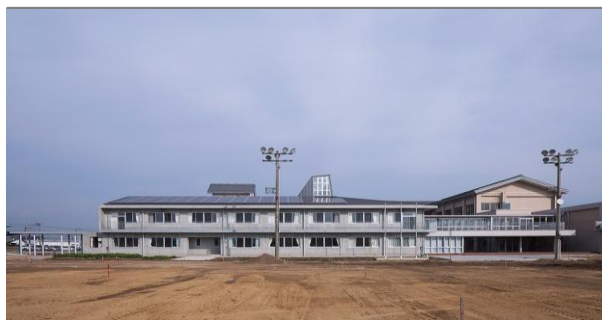
写真① 改築特別教室棟外観南側 改築工事により平成26年11月に竣工。 外壁一部 神川産杉板型枠打放コンクリート仕上げ
