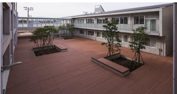
写真③ 外のにわ（パティオ部デッキ） 耐久性の高い人工木材を使用し、木の温かみを感じさせるオープンスペースとしての活用
