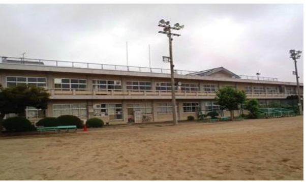
写真⑥ 旧特別教室棟（外観） 昭和40年9月竣工し、平成25年8月にⅠ期解体、 平成26年7月にⅡ期解体 鉄筋コンクリート造
