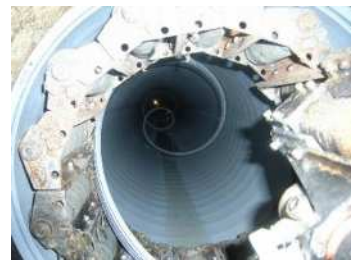
下水道管の補修工事
