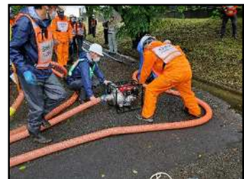
(排水ポンプ設置)
