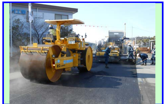
施工中（舗装敷均し初期転圧）
