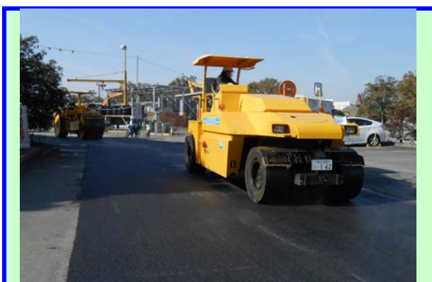
施工中（2次転圧）
