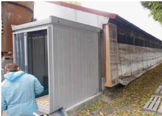
前室（物置倉庫）設置事例
