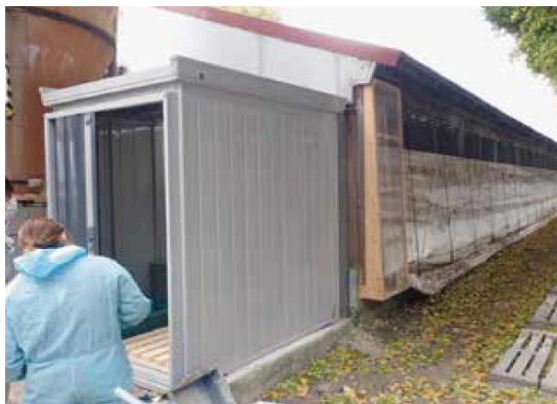
前室（物置倉庫）設置事例
